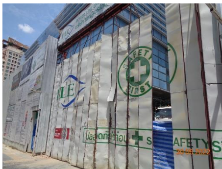
ภาพที่ 2.2-30 การปิดม่านทางเข้า-ออกพื้นที่ก่อสร้าง
