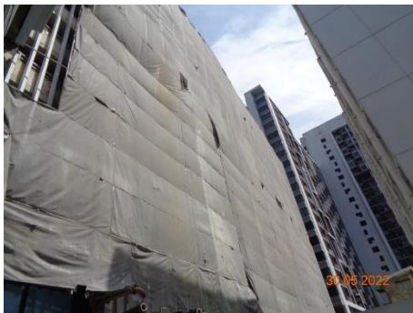
ภาพที่ 2.2-41 การติดตั้ง Mesh Sheet
