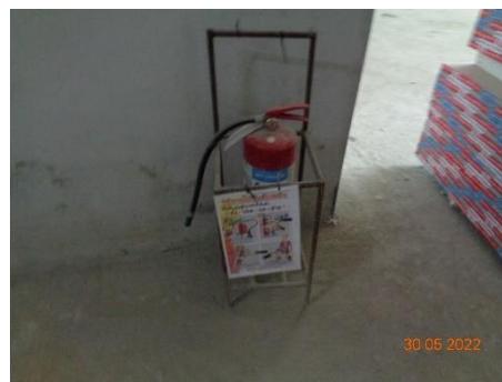
ภาพที่ 2.2-32 การติดตั้งถังดับเพลิงและป้ายแนะนำวิธีการใช้ถังดับเพลิง
